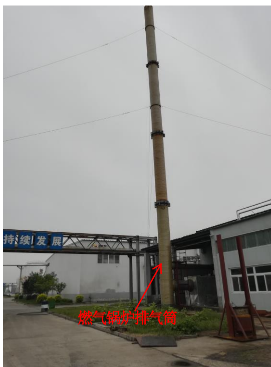
图 4-2 锅炉烟气治理设施建设情况
