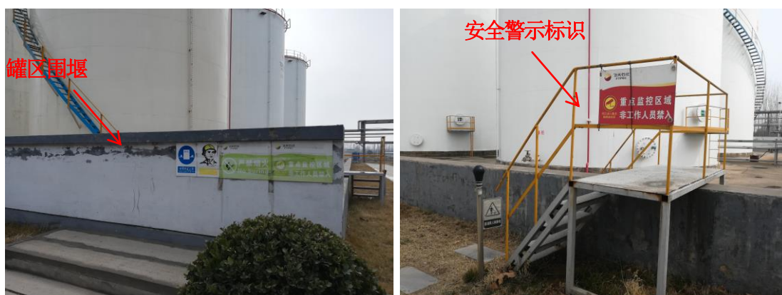
图 4-9 新增罐区风险防范措施建设情况
