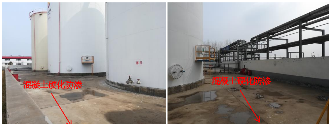
图 4-8 新增储罐区防渗措施建设情况
