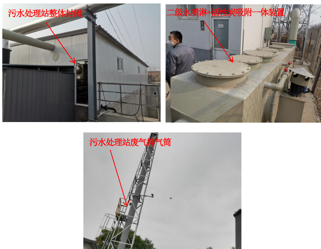
图 4-4 污水处理站废气治理设施建设情况
