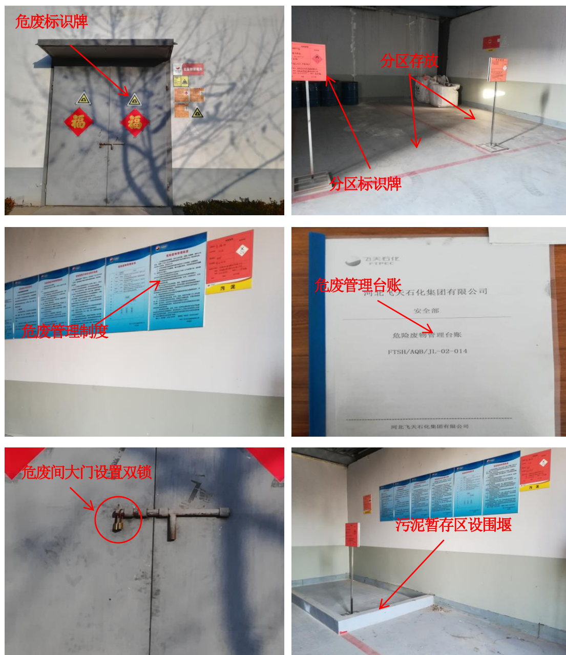
图 4-7 危废暂存间建设情况
